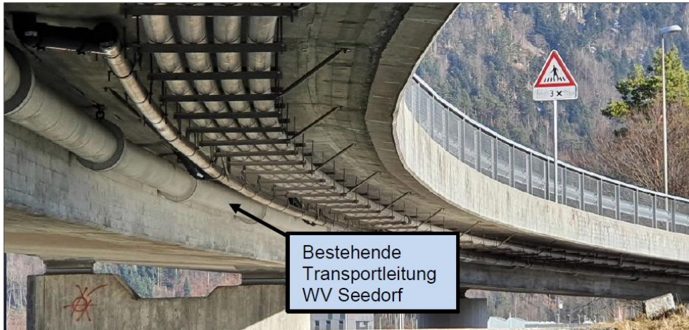
Abbildung 3: Übersicht bestehende Transportleitung (Quelle: IUB AG, Altdorf)
